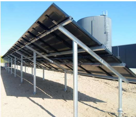
Anlæg med vores stativer til 2 rækker i 25 grader på 100 Kw.
